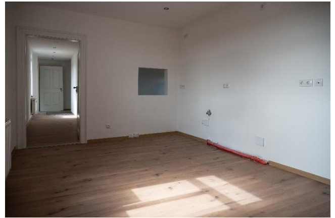
Die frisch sanierte Küche mit Durchreiche zum Wohnzimmer
