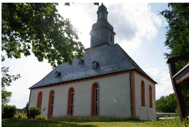
Kreuzkirche in Ebersgrün; Dachsanierung, Glockenstuhl 2018; Trockenlegung außen 2023
