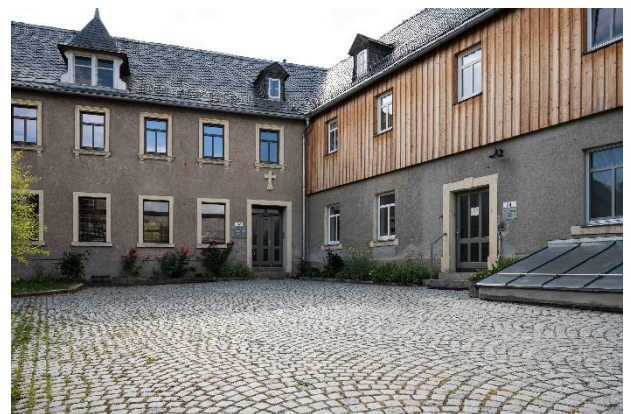
Der Innenhof des Pfarrhauses mit Pfarrwohnung/ Pfarrsaal (links) und Pfarrbüro, Archiv, Kopierraum und 2 Wohnungen (rechts)
